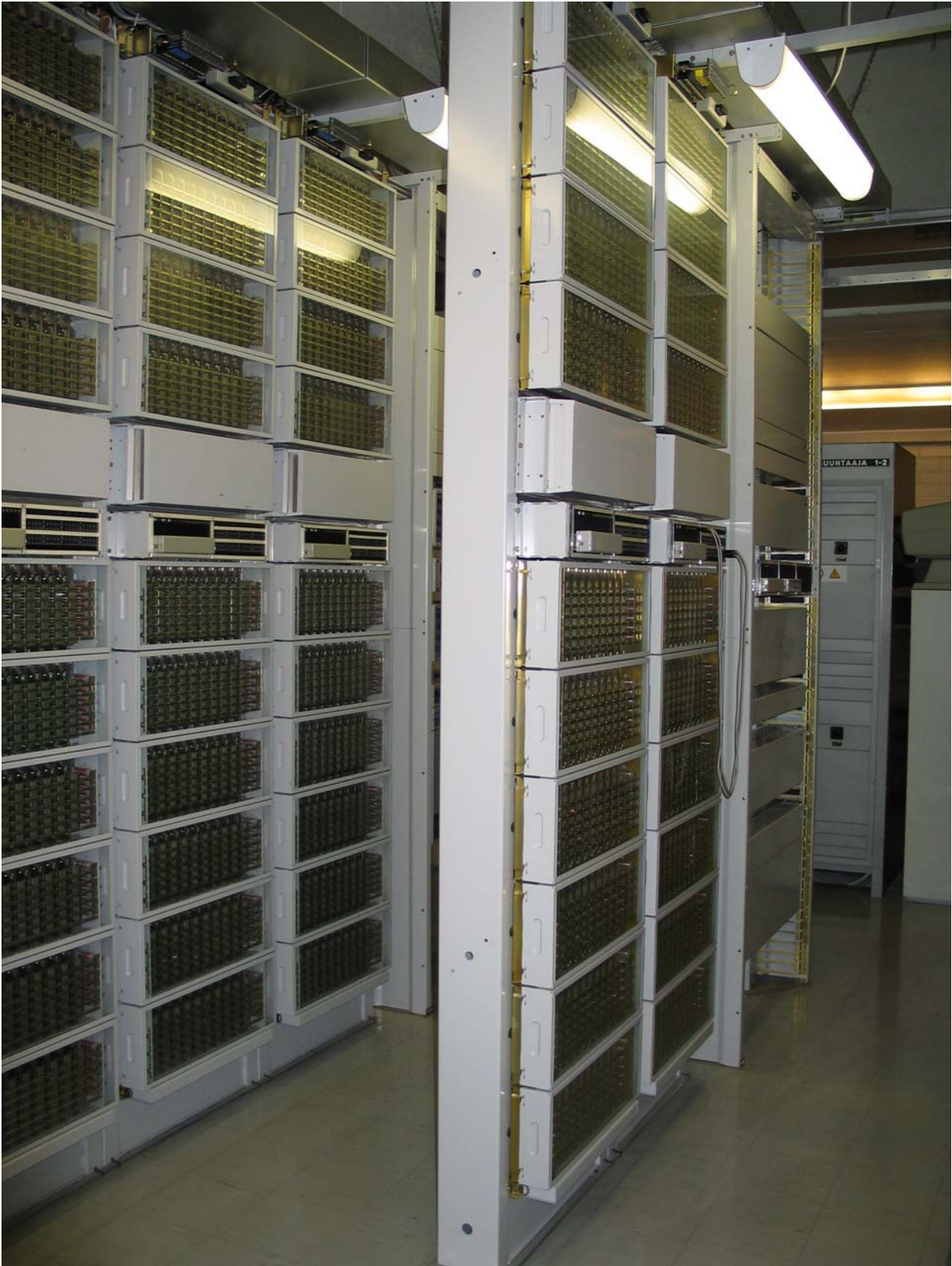
Bild 1. Del av GV-steget i ARF-stationen i Moisio, Åbo
